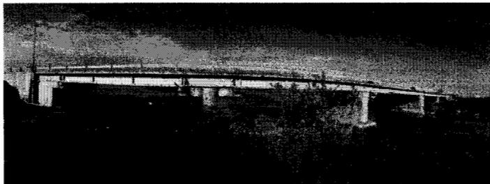
rappresentano l'aggetto costituito da una mensola. Per ogni appoggio vi sono 5 mensole ,poste ad interasse di ml. 2,10, mentre le travi in precompresso sono 6.
